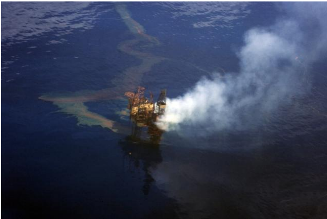
Figura 3 Piattaforma West Atlas della concessione Montara danneggiata che rilascia petrolio in quantita’ incontrollata, prima di andare a fuoco. L’incidente e’ dell’Agosto 2009 ed e’ avvenuto nonostante si usassero le migliori tecnologie disponibili.
