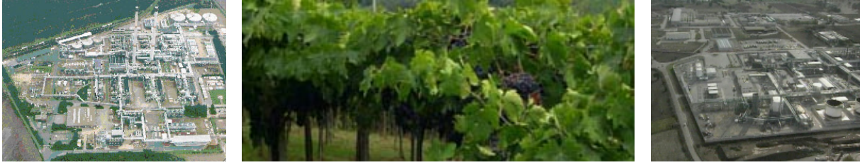
FIG. 1: A sinistra una veduta aerea del centro di idro-desulfurizzazione del petrolio a Grossenkneten, in Germania. Al centro vigneti tipici d'Abruzzo. A destra una veduta aerea del centro di idro-desulfurizzazione del petrolio a Viggiano, in Basilicata.
