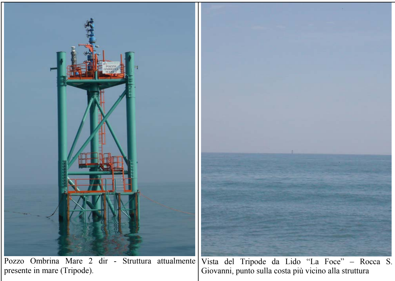
Figura 4.4.2.1.a – Struttura a traliccio esistente – Testa pozzo Ombrina Mare 2 Dir.
