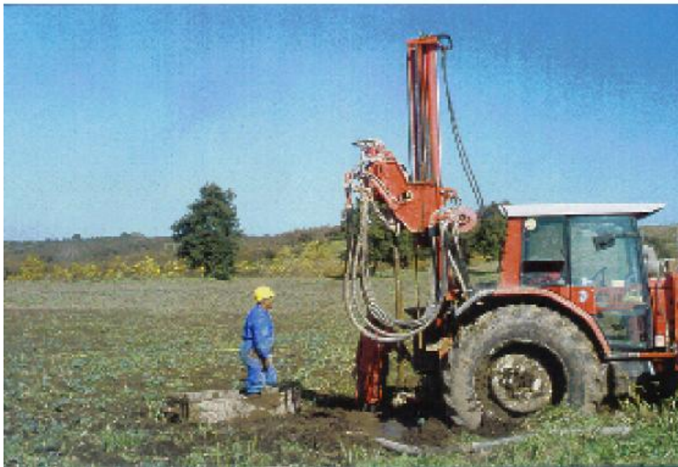
Fig. 7 – Gruppi di perforazione su camion o trattore supportati da autobotte
