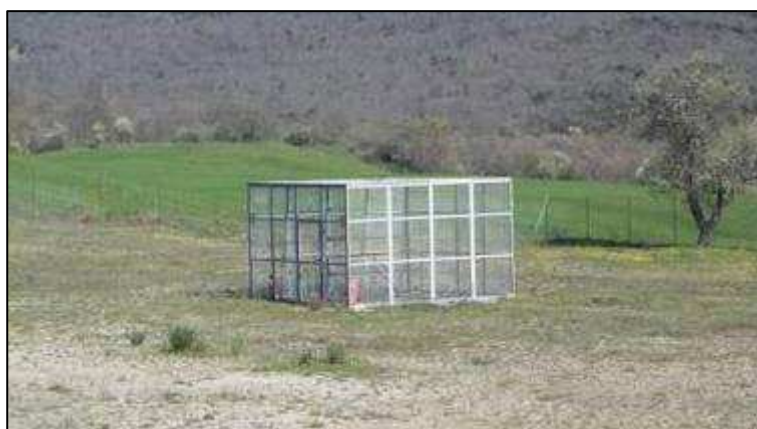
Figura 3.11: Esempio di pozzo completato e recintato con gabbia metallica (con demolizione delle superfici impermeabilizzate)
