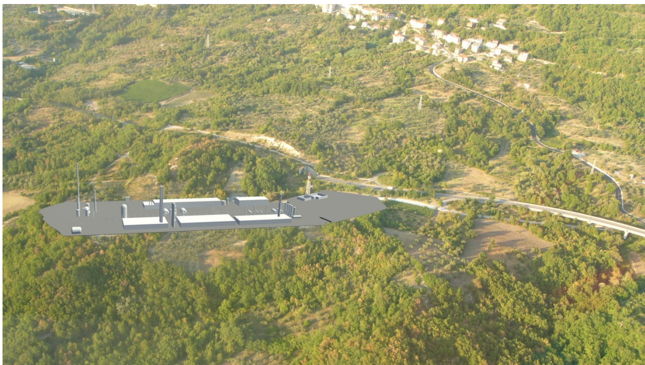
Foto 8. Ricostruzione della visione aerea della centrale. In alto via Pagliarone e via Roma (Bomba)
